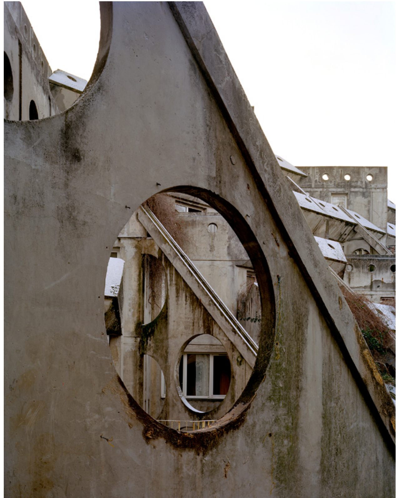
Cité Desnos_Cité des Poètes Pierrefitte Sur Seine - Paris, 2010 # 054_2010 © gian paolo minelli
