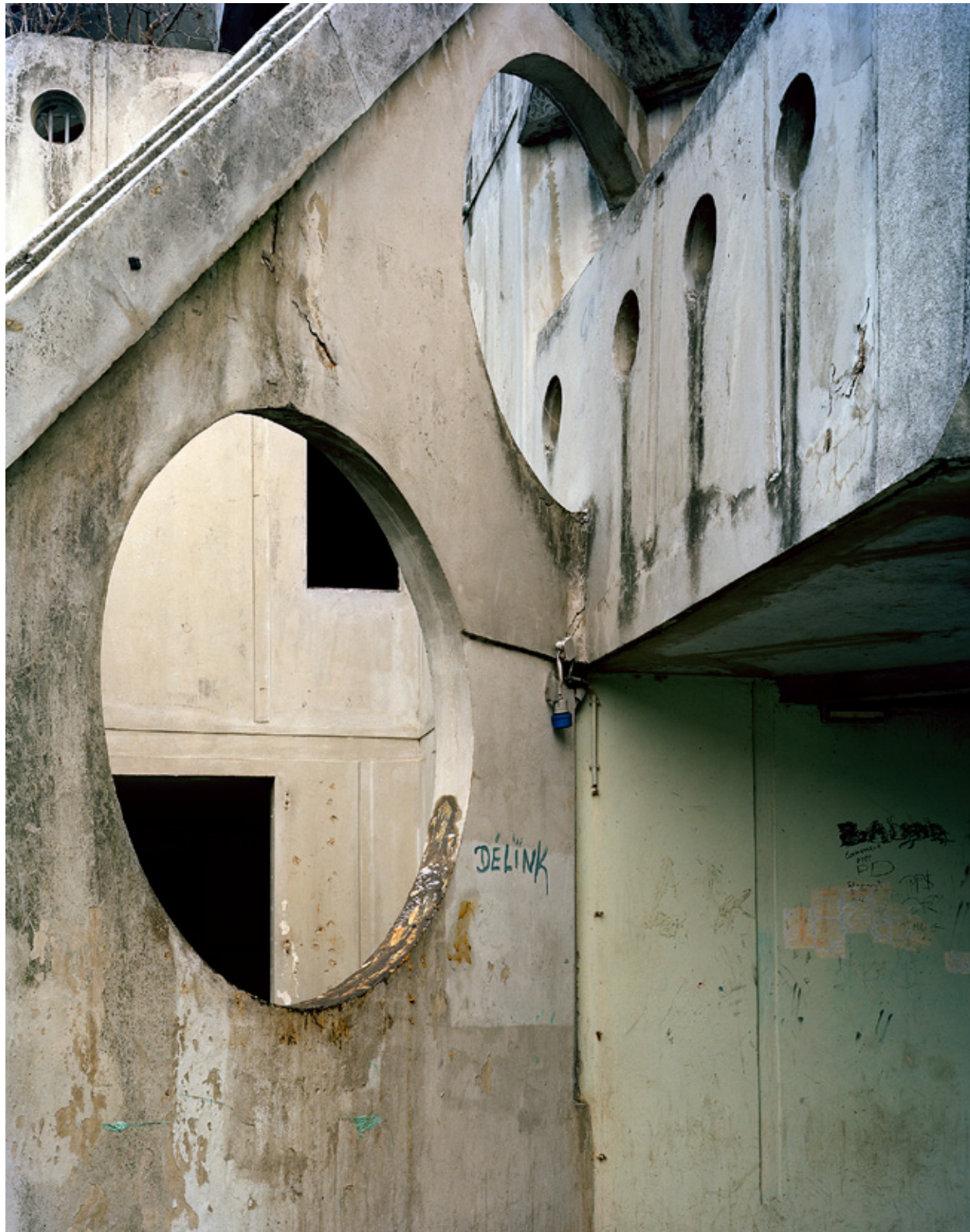
Cité Desnos_Cité des Poètes Pierrefitte Sur Seine - Paris, 2010 # 053_2010 © gian paolo minelli
